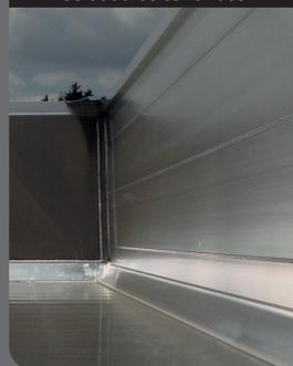
Un proceso de soldadura continua que garantiza una estanqueidad perfecta al nivel de ensamblajes.
